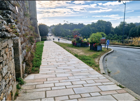
Dallage du trottoir au pied du château
